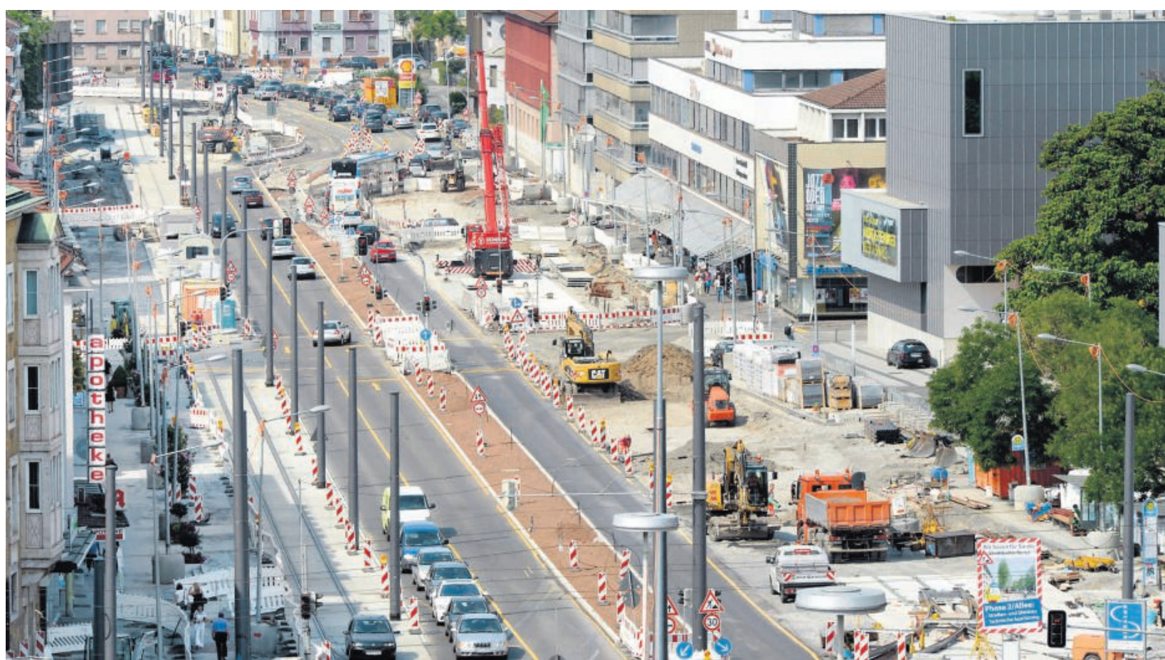
Frequenzzrückgang im Handel wegen der Arbeiten für die Stadtbahn auf der Allee: Die Händler haben unzureichendes Baustellenmanagement beklagt. Foto: Archiv/Berger
